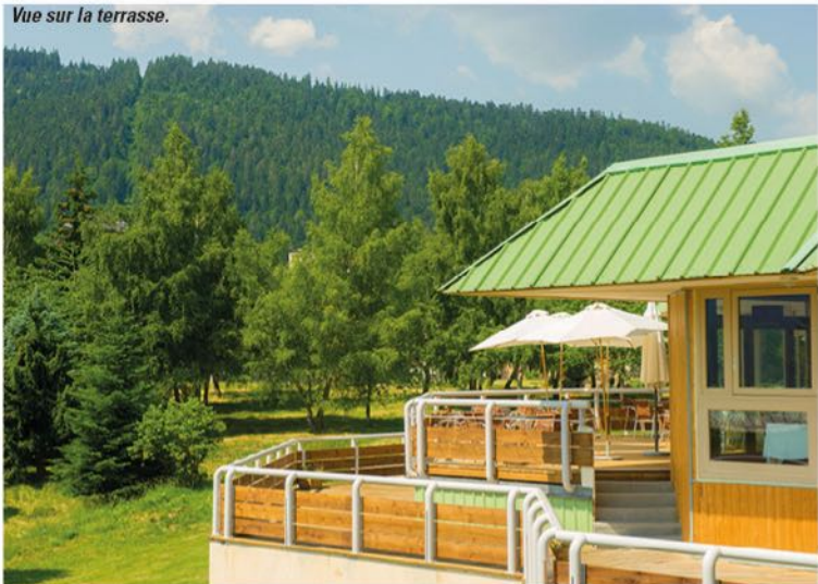
Vue sur la terrasse.
